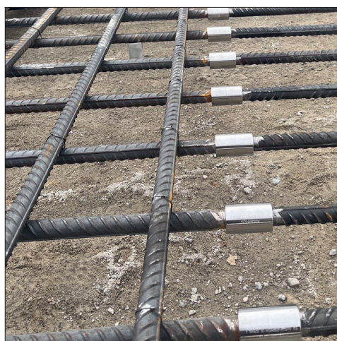
اجرای کوپلینگ برای میلگردهای فونداسیون
