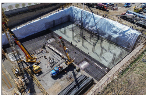
بتن ریزی فونداسیون
