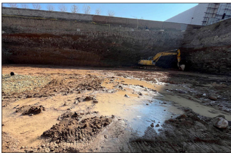
گودبرداری محل احداث بلوک A
